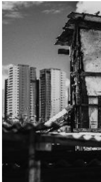
Figura 02: Vista das palafitas na Vila Santa Luzia, bairro da Torre, no Recife. 2018
